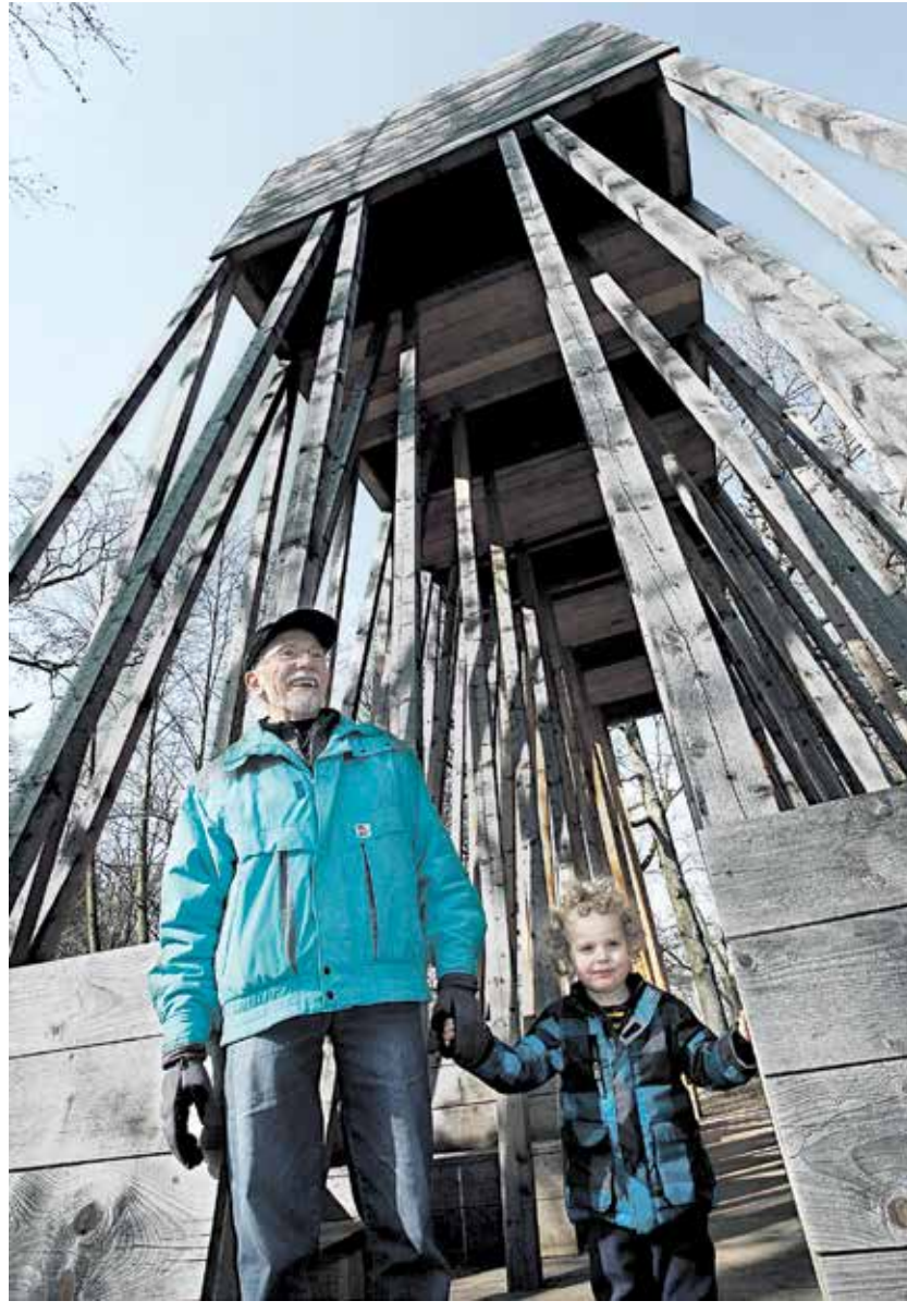
Eine zusätzliche Attraktion für Besucher bildet Claus Burys Raststätte auf der alten Freilichtbühne in der Nähe des Steinbockgeheges.
